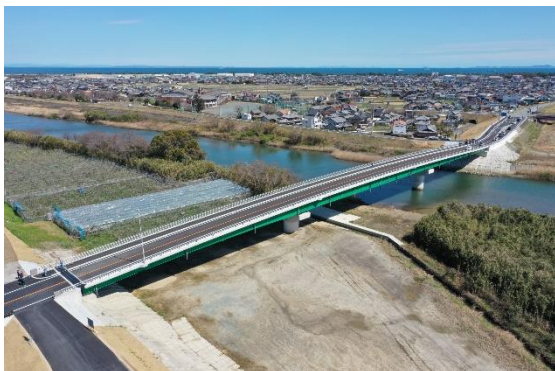
一般県道香良洲公園島貫線(香良洲橋)橋梁耐震対策事業 (津市)
