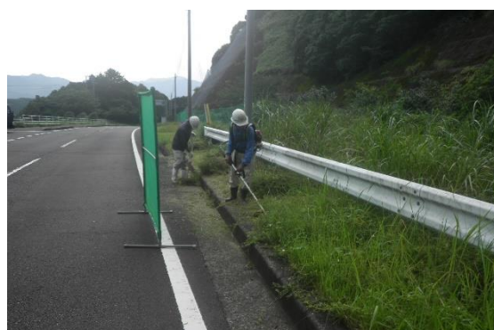
道路の除草作業 (尾鷲市)
