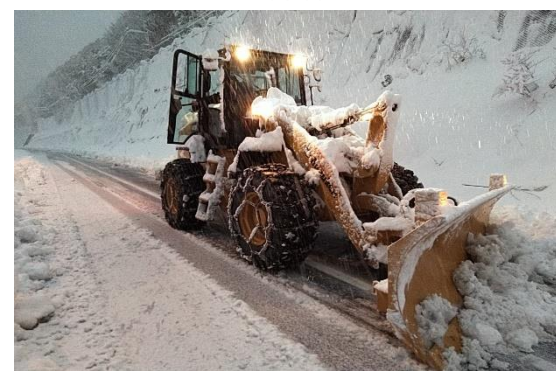
道路の除雪作業 (いなべ市)
