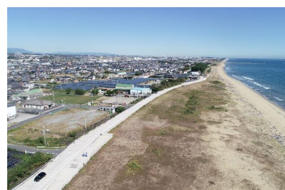
上野地区海岸高潮対策事業 (津市)
