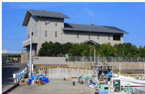
漁業集落排水処理施設
