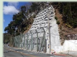
道路の土砂崩れ対策
