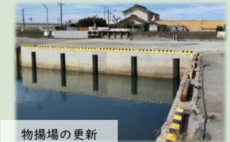
物揚場の更新
