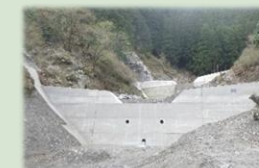
治山ダムの整備 (松阪市)
