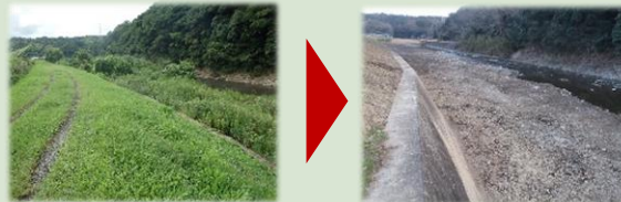
河川の堆積土砂撤去（榑原川（津市））
