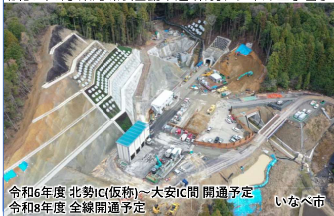
令和5年3月 東海環状自動車道 県境トンネル工事着手
