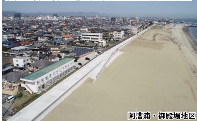
令和5年度 津松阪港直轄海岸 全工区整備完了予定
