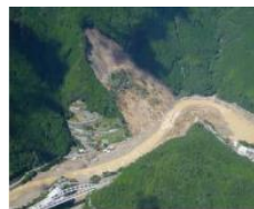
深層崩壊発生直後 (五條市清水地区)
