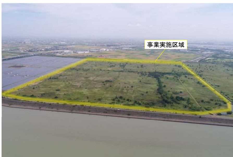
図 2-2 事業実施区域の現況 (木曽川上空より撮影、撮影日：令和 3 年 8 月 26 日)
