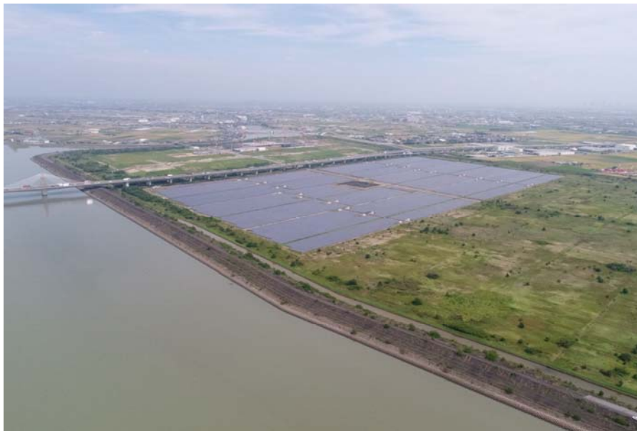
図 1-2 新エネルギーランド(木曽岬干拓地メガソーラー発電所)の現況 (木曽川上空より撮影、撮影日：令和 3 年 8 月 26 日)
