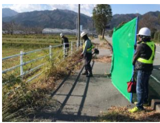
地域の建設企業による除草作業
