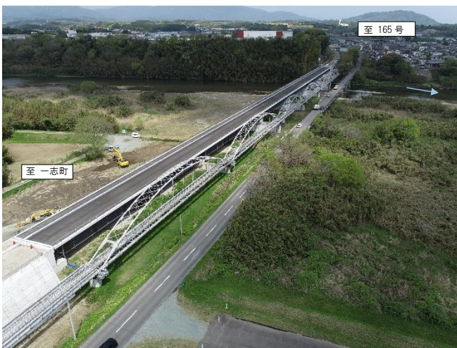
県道 一志出家線 (中川原橋)
