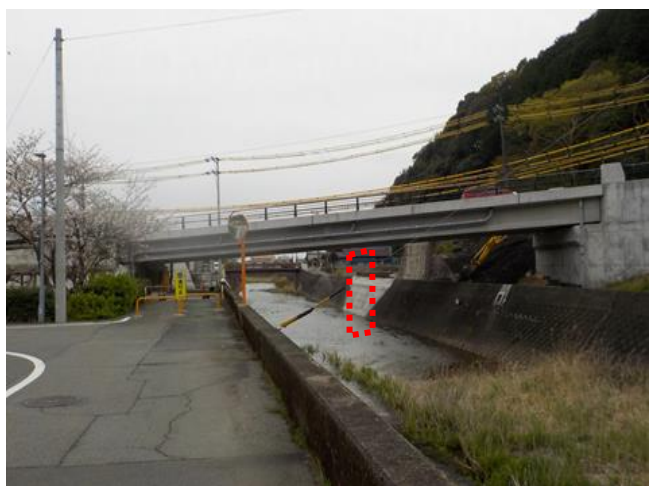
国道 260 号（東宮橋）
