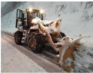
地域の建設企業による除雪作業
