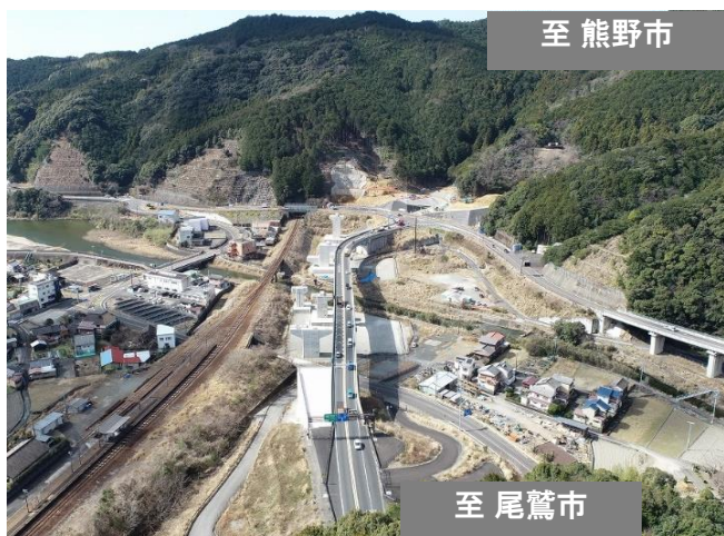
熊野道路（熊野第一トンネル）
