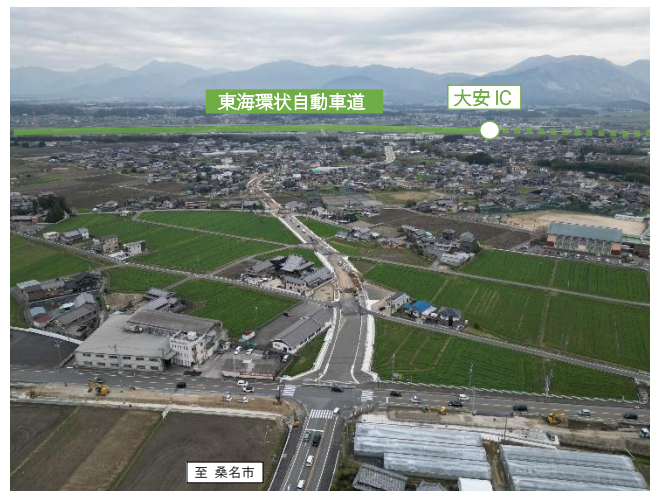
国道 421 号 大安 IC アクセス道路
