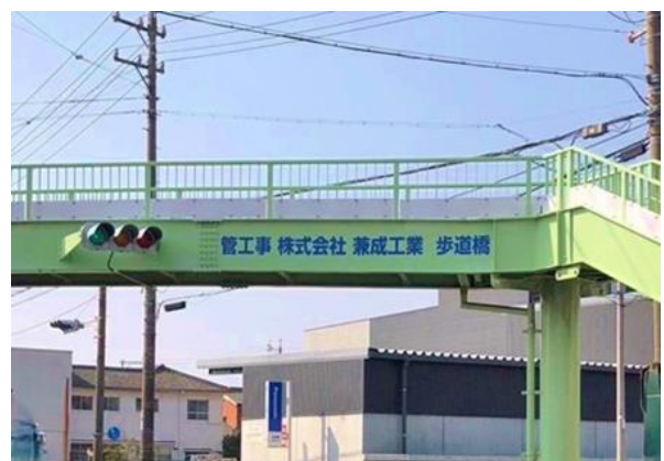
七つ屋町歩道橋 「管工事 株式会社 兼成工業 歩道橋」 （四日市市）
