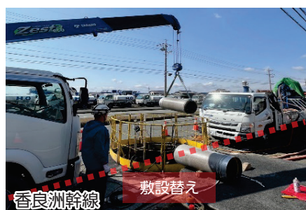
耐震性を有する管きょへの敷設替え
