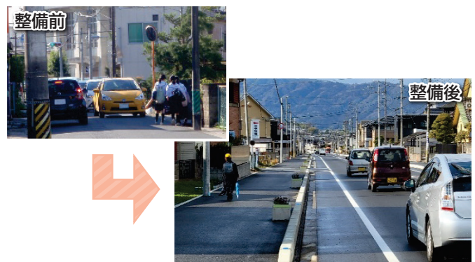
(都) 服部橋新都市線 (伊賀市) における街路整備
