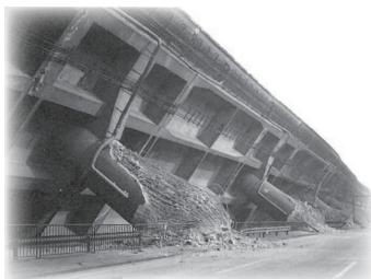
阪神淡路大震災(兵庫県神戸市) 写真提供：国土交通省近畿地方整備局
