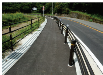
県道亀山停車場水湊線(亀山市)
