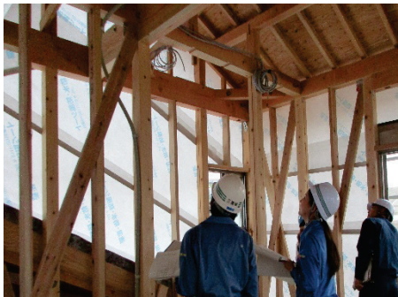
建築基準法による中間検査
