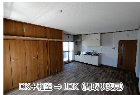
住戸内改修工事
