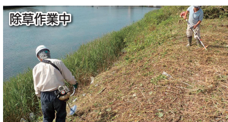
堤防の点検を実施するため、必要な箇所の除草を実施しています。
