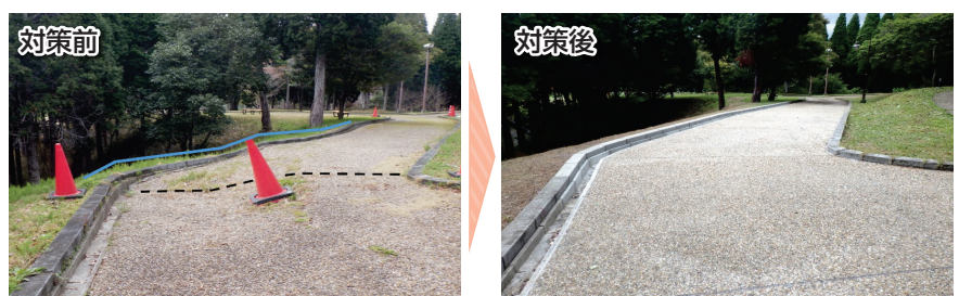
亀山サンシャインパーク (亀山市) における老朽化対策 (園路舗装の更新)
