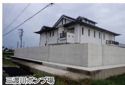
津波からポンプ場を守る防潮壁の整備
