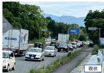
⑫国道 365 号(四日市市)
