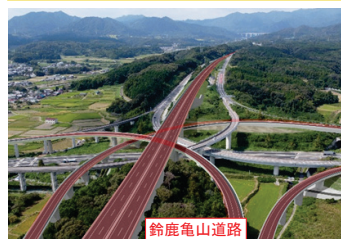
⑧鈴鹿亀山道路(鈴鹿市・亀山市)
