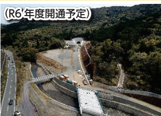
⑨国道 167 号磯部バイパス(志摩市)
