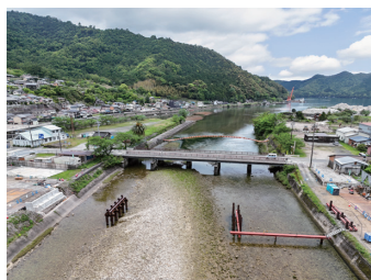
⑯国道 311 号(尾鷲市)
