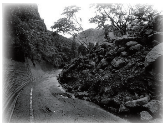
平成 23 年紀伊半島豪雨(熊野市)
