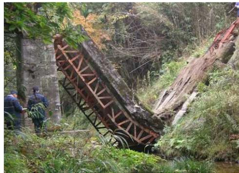
写真1 老朽化が原因で落橋した国内事例
