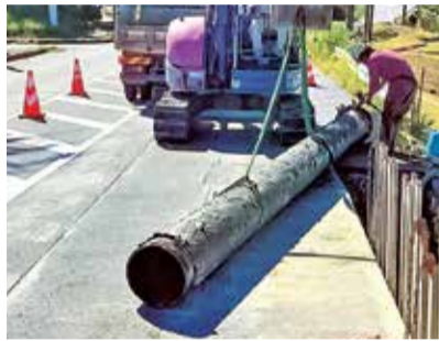
老朽化した水道管の撤去
