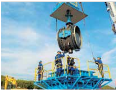
水道管内の水流を制御するための「制水弁」の取替
