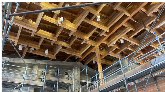
梁の建方後、屋根を施工し、全て荷重が載った状態で、仮設の土台(支保工)を外した結果、梁のたわみ量は最大値で6mm程度であり、設計時の想定内だった。
