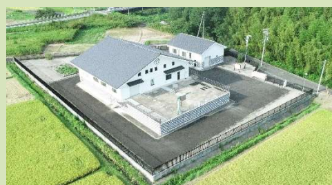
(農業集落排水施設)
