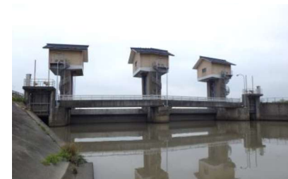
笹笛川防潮水門(明和町)
