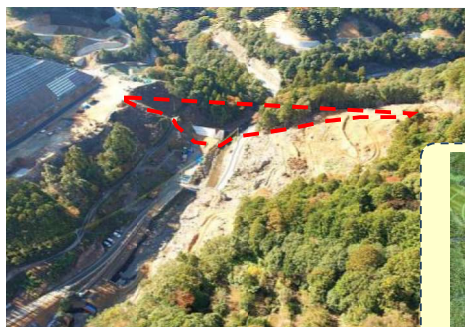
鳥羽河内ダム(鳥羽市)
