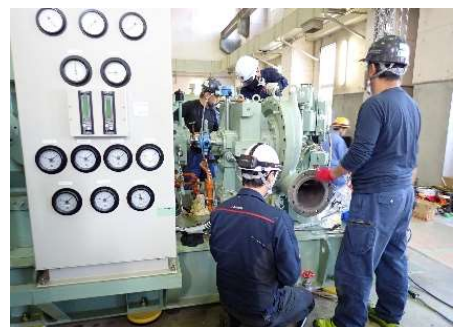
下水処理設備の点検状況
