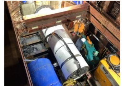
内宮幹線管渠延伸工事
