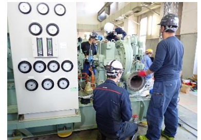
下水処理設備の点検状況
