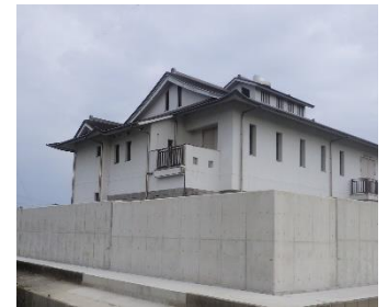
三渡川ポンプ場の防潮壁
