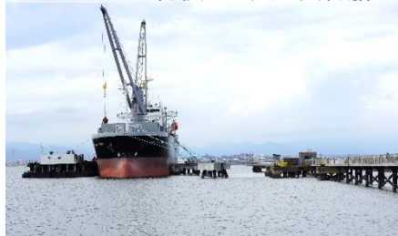
伊倉津地区の大型荷役機械
