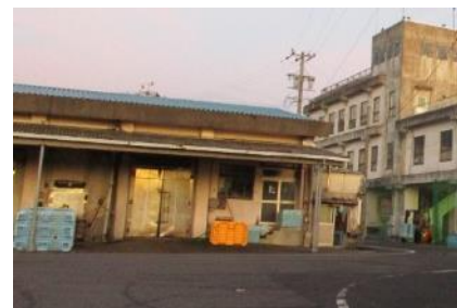
冷凍・冷蔵庫
