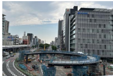
円形デッキ工事状況写真
