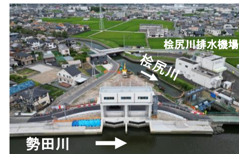
松尾川排水機場ポンプ増強工事(R6.7時点)
