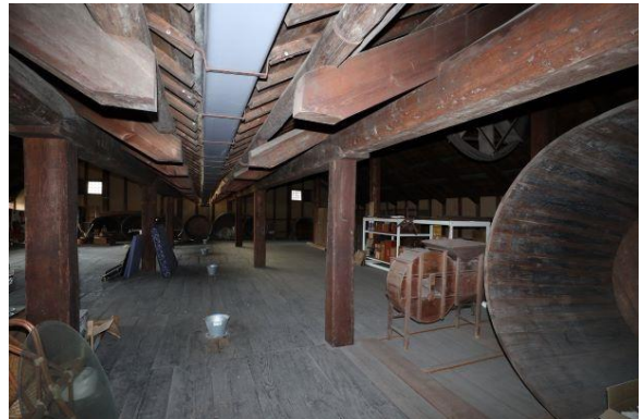
2 階内部 2 棟接合部
