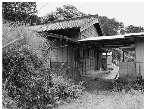
図 146 江戸屋跡の建物(解体)と熊野道
