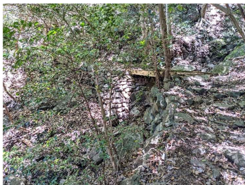
図 43 石垣と木橋 (紀北町側から撮影)
