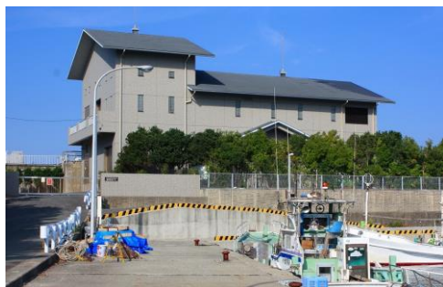
漁業集落排水処理施設
