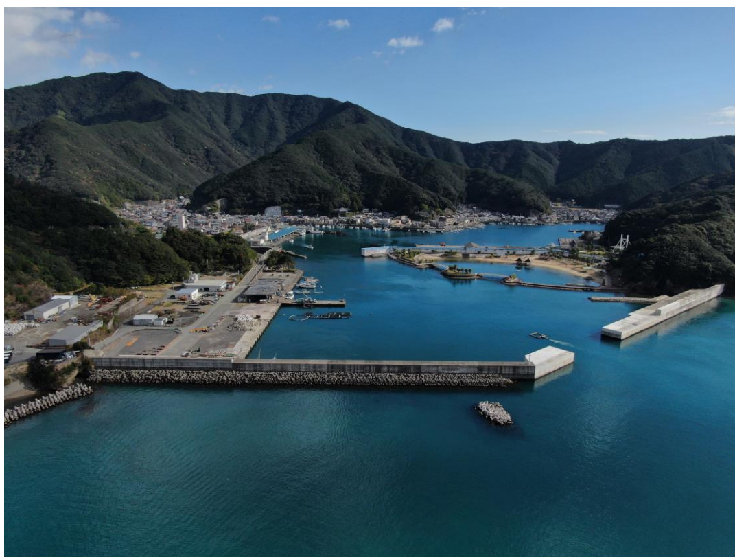
錦漁港における耐津波防波堤の整備
