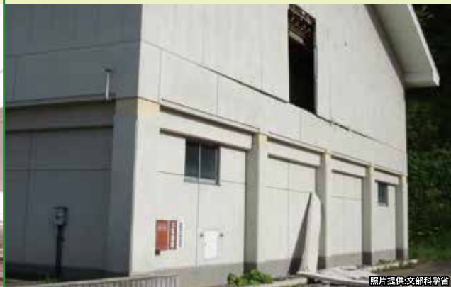
⑥ 外墙壁剥落
