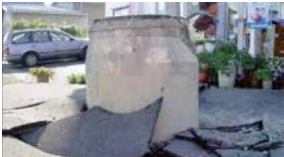
穿出地面的下水管道
