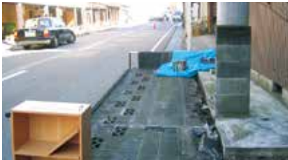
倒塌的砖墙
