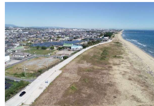
上野地区海岸高潮対策事業 (津市)
