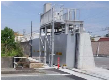
陸閘の改築 (衣浦港海岸：愛知県高浜市) 資料：愛知県
