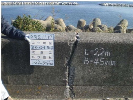
波返し工ひび割れ (三重県鈴鹿市) 資料：三重県
