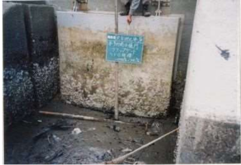
ヘドロの堆積 (フラップゲート) 資料：三重県
