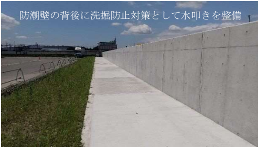
堤防の耐震化（名古屋港海岸：愛知県名古屋市）
