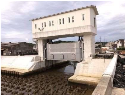
水門の改築(耐震化、自動閉鎖化) (美浜海岸布土川樋門：愛知県美浜町)
