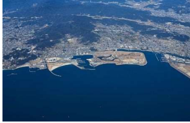
覆砂箇所（三河港：愛知県蒲郡市）
