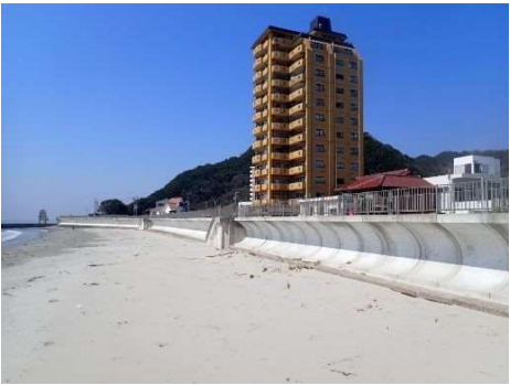
老朽化した堤防の前面に大型波返し護岸（高さを低減）を設置（南知多海岸） 資料：愛知県
