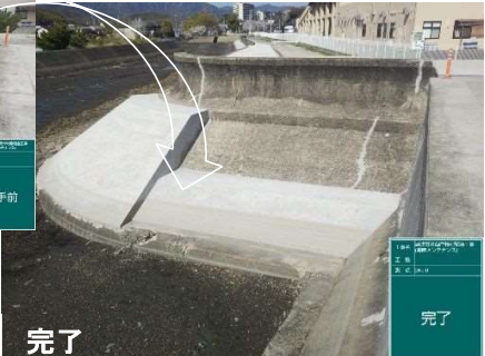
堤防の補修 (蒲郡海岸：愛知県蒲郡市) 資料：愛知県
