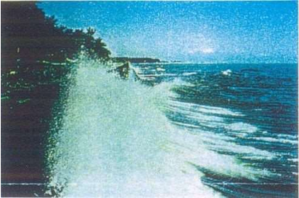
越波状況 （三重県伊勢市） 資料：「伊勢湾沿岸整備マスタープラン」（三重県）
