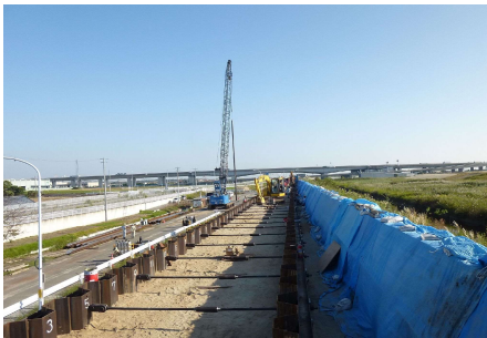
堤防の耐震化（海部海岸：愛知県弥富市）
