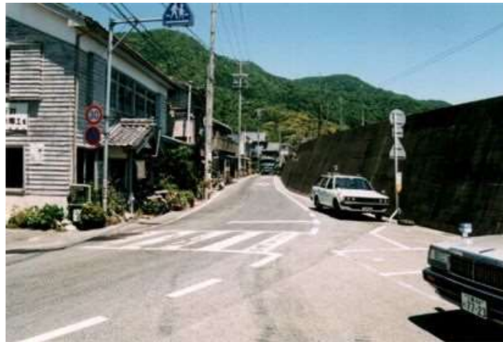
堤防によるアクセスの遮断（費浦） 出典：三重県資料
