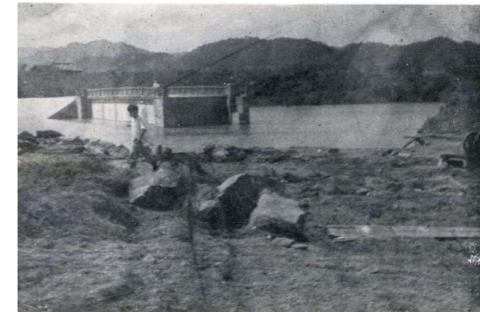
一般国道の流失（熊野市志原地内）
