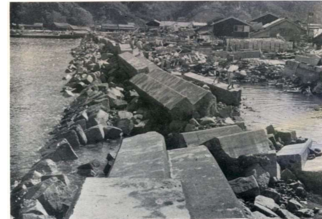
ずたずたになった港湾施設（北牟婁郡長島港）
