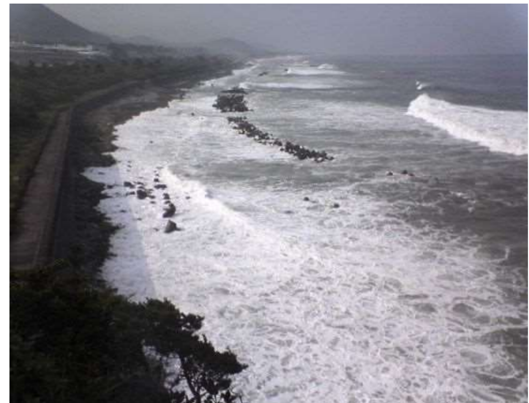
侵食後（平成 27 年 9 月撮影）
