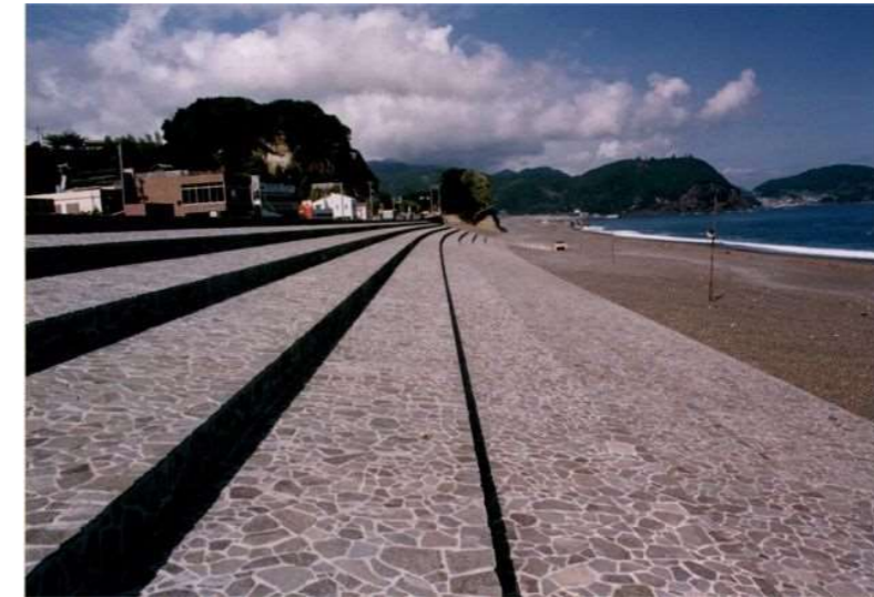
緩傾斜護岸（熊野海岸 有馬地区） 出典：三重県資料
