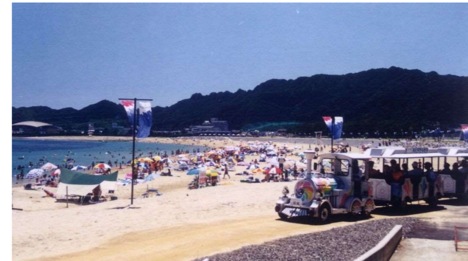
緩傾斜護岸（那智勝浦海岸：平成 11 年撮影） 出典：和歌山県資料
