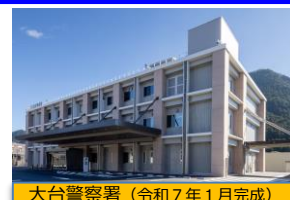
大台警察署（令和7年1月完成）
