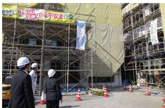
【庁舎建設現場の視察】
