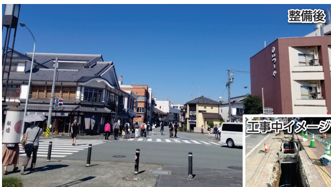
(都) 外宮度会橋線 (伊勢市) における電線類の無電柱化
