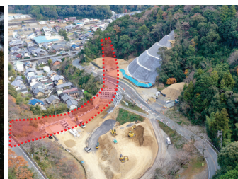
⑲国道 260 号(南伊勢町)
