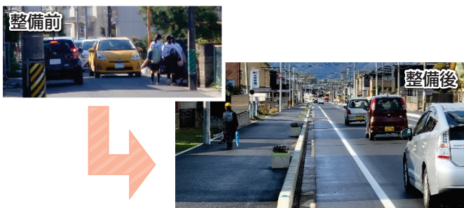
(都) 服部橋新都市線 (伊賀市) における街路整備
