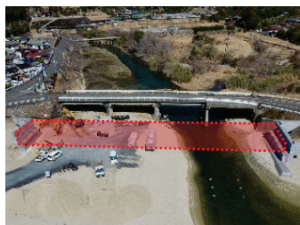
⑰国道 311 号(熊野市)
