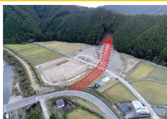
⑨国道 422 号(紀北町)
