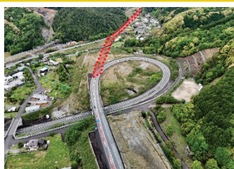
⑪国道 167 号(志摩市・鳥羽市)
