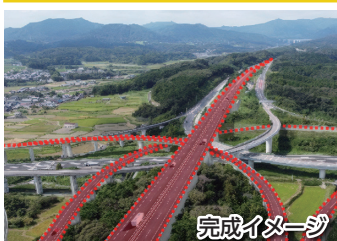
⑧鈴鹿亀山道路(鈴鹿市・亀山市)
