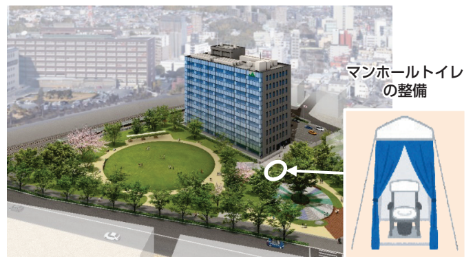
県庁前公園 (津市) におけるマンホールトイレ等の整備
