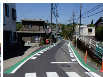
グリーンベルト設置
