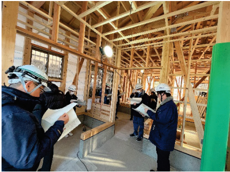
建築基準法による中間検査
