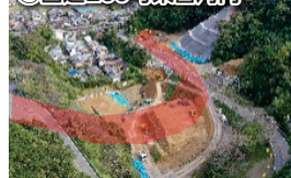
⑦国道260号東宮河内
