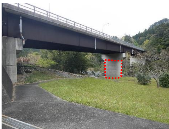
国道 166 号（新赤桶橋）
