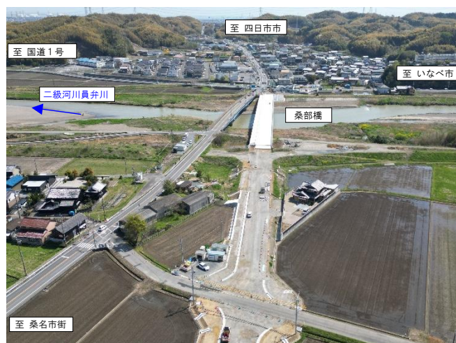
県道 桑名大安線（桑部橋）
