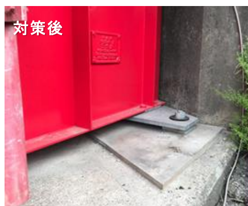
支承の交換⇒健全性を回復
