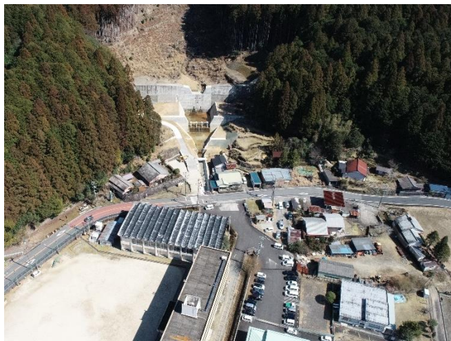
●通常砂防事業（雨東谷：熊野市）
