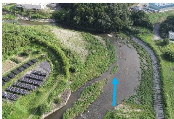
【長野川】 堆積土砂撤去（津市庄田町）
