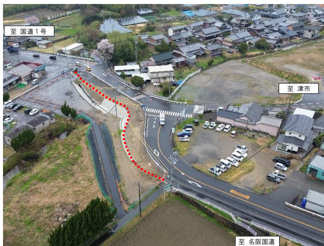
県道 津関線（古厩交差点）
