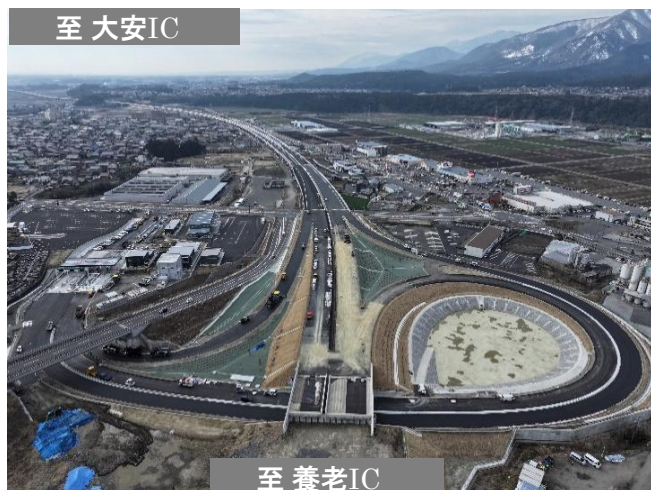
東海環状自動車道（いなべIC）
