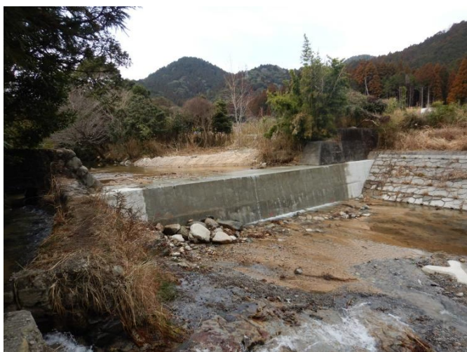
●砂防メンテナンス事業（鈴鹿川床固工：亀山市）
