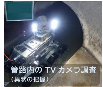
下水道管路の調査
