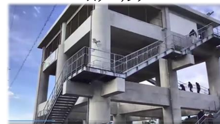
津波避難タワー (志摩市)
