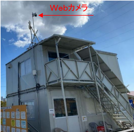
ケーソン設備操作室への監視カメラ設置状況
