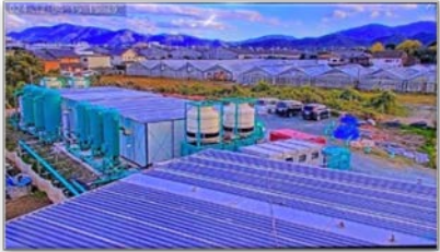
設備ヤードの監視状況
