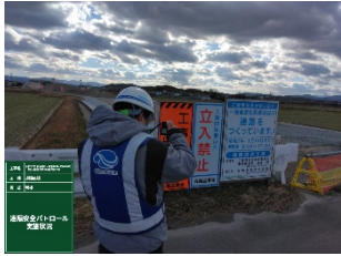
現場代理人が現地をWeb配信
