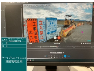
PCで現場状況を確認
