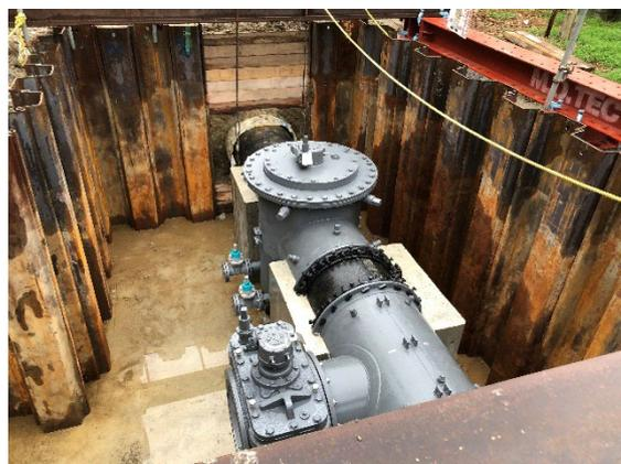
不断水工法\*による制水弁設置状況
