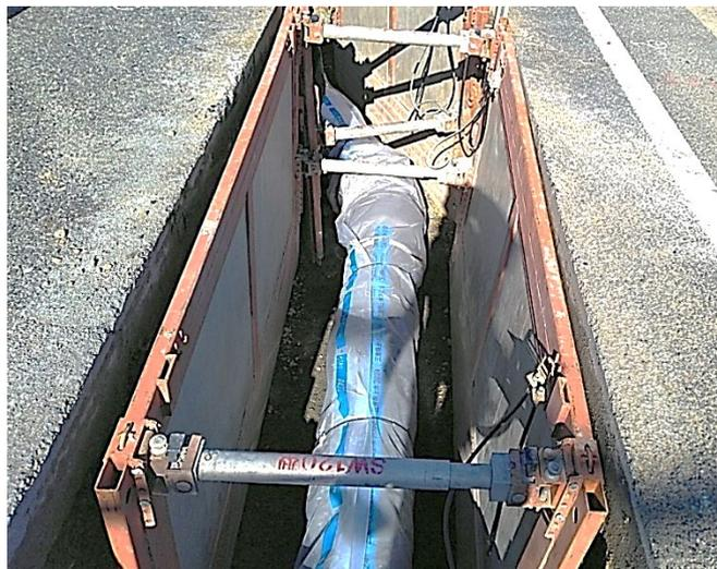
送水管布設替工事の施工状況（桑名市）
