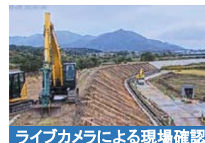
ライブカメラによる現場確認
