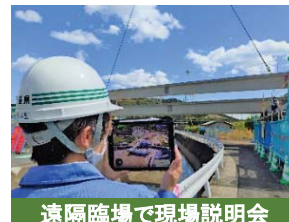
遠隔臨場で現場説明会
