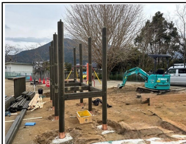
写真4 木製遊具工事中 組立状況
