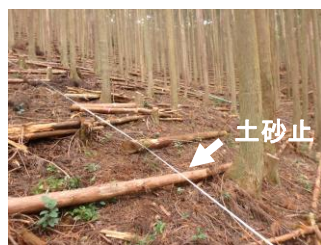
伐倒木を利用した土砂止の設置
