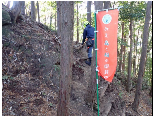
写真2 大里地区（京城跡）緑地整備（実施中）
