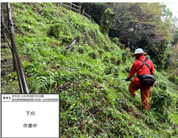
写真5 鵜殿地区ふるさと歴史公園下草刈（実施中）
