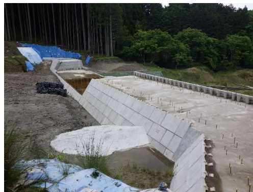
受賞した現場（完成写真）
