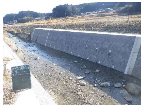
受賞した現場（完成写真）
