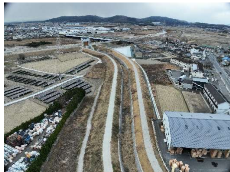
受賞した現場（完成写真）
