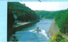
深谷水道 大王町と志摩町の間にある英虞湾（あごわん）と太平洋を結ぶ長さ660mの人工の水路。漁船の便と海水の動きを良くするために昭和七年に作られました。
