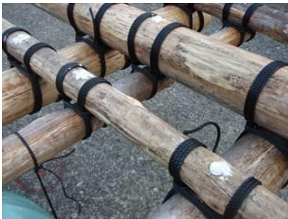
木枠の固定、腐食状態の確認
