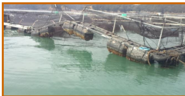
【東北地方太平洋沖地震津波の被害状況】
