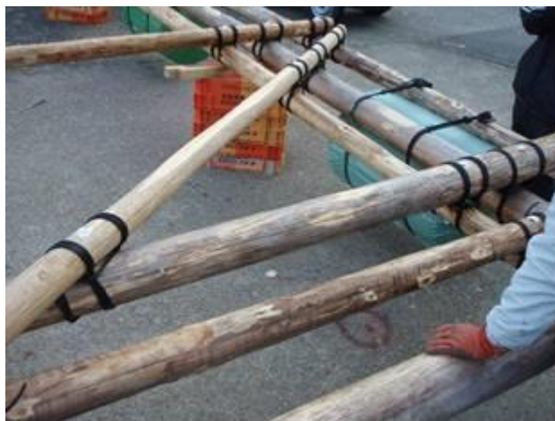
「すじかい」による木製筏枠の補強 (21 ページ参照)
