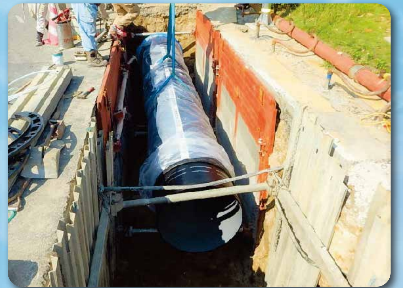
配水管布設替工事の施工状況
