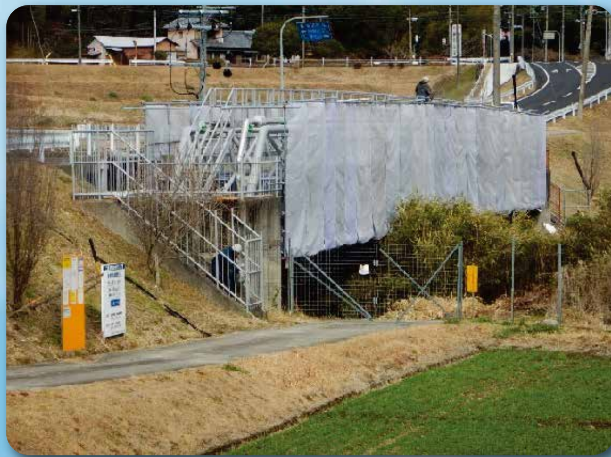
塗装塗替中の水管橋
