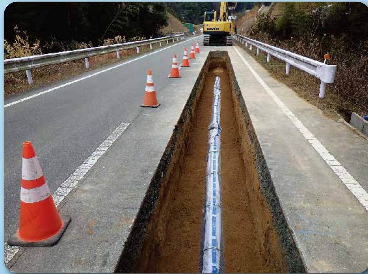
耐震管への布設替え
