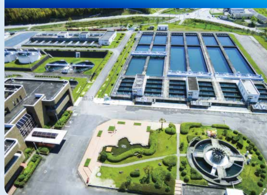
多気浄水場 (多気町)
