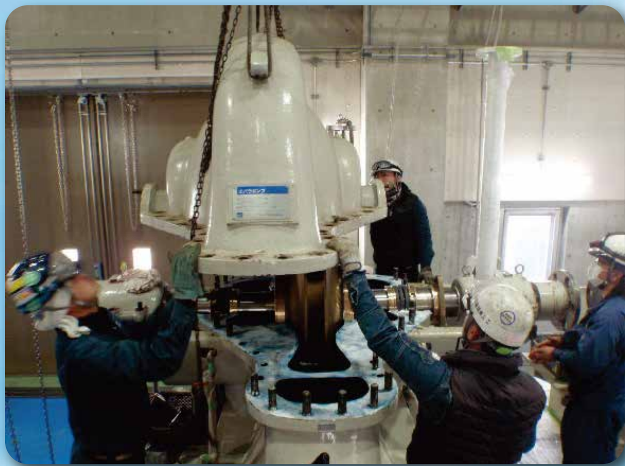
分解点検中のポンプ設備
