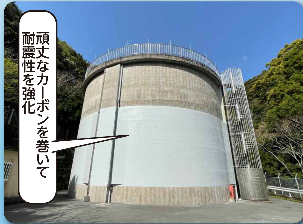
調整池の耐震補強
