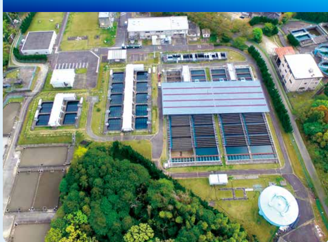
高野浄水場 (津市)
