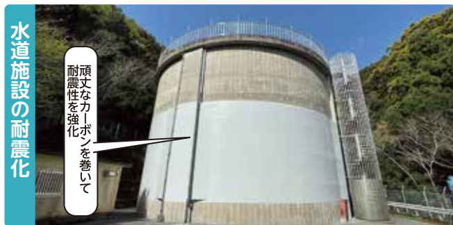
調整池（水を貯めるタンク）の耐震補強
