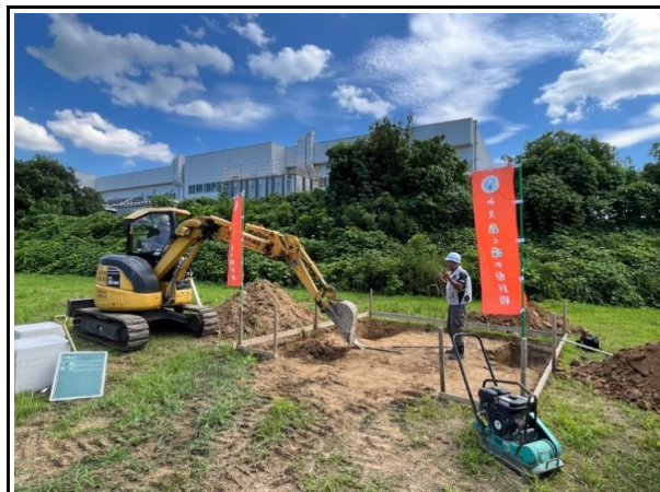
写真2 施工中 啓発用のぼり設置状況
