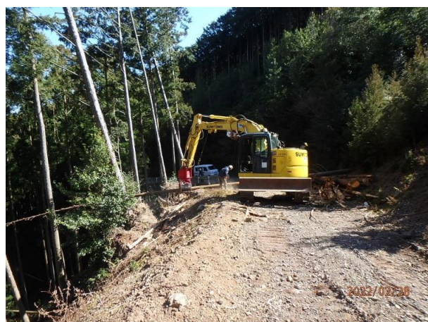
写真12 大紀町崎船久保地区 作業中
