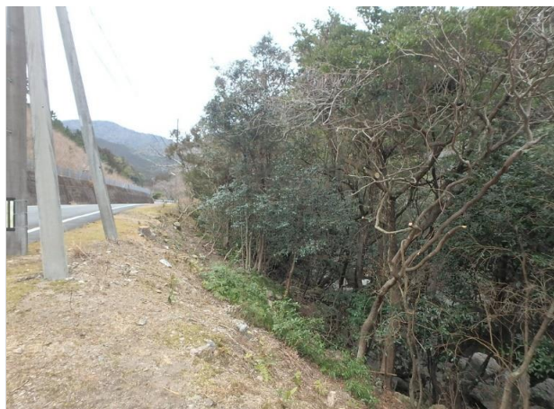
写真7 大紀町木屋竹利地区 完成
