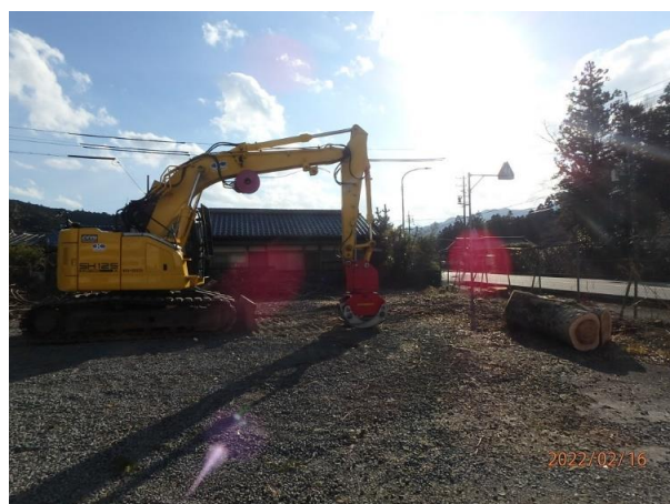
写真12 大紀町滝原下沖地区 作業中
