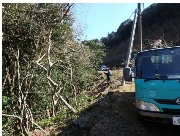
写真6 大紀町木屋竹利地区 作業中
