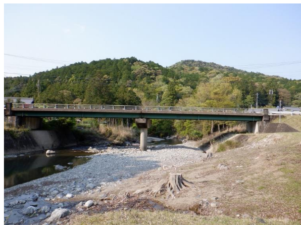
写真8 大紀町永会藤安場内 危険木除去後
