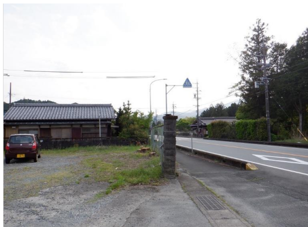
写真13 大紀町 滝原下沖地区 作業中
