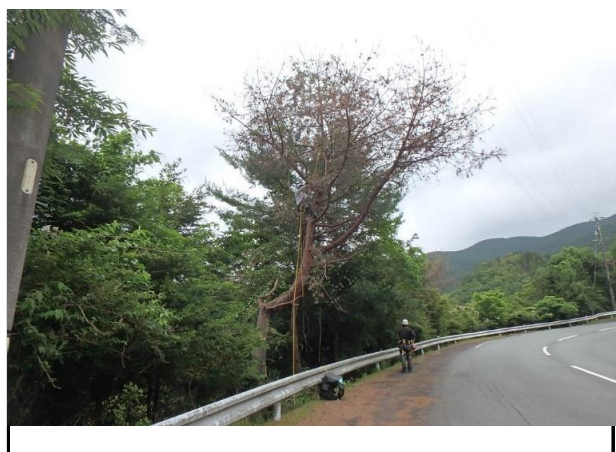
写真9 大紀町永会八ヶ河内地区 作業中
