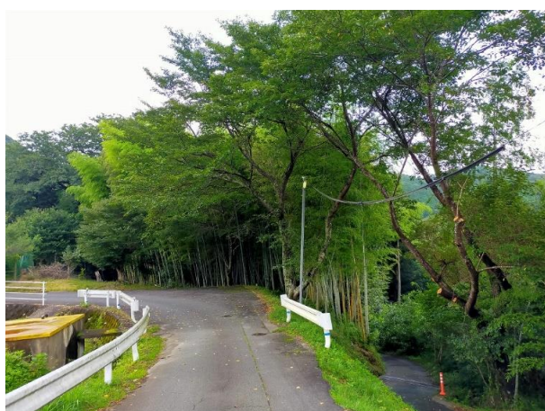
写真16 大紀町 野原久保地区 完了後
