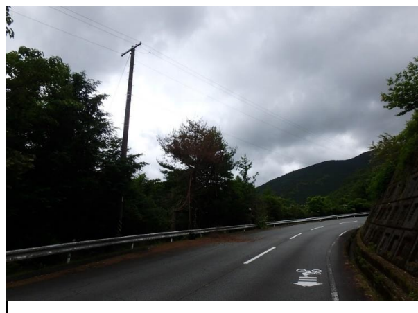
写真10 大紀町永会八ヶ河内地区 完成
