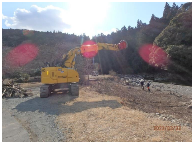
写真7 大紀町永会藤安場内 作業中
