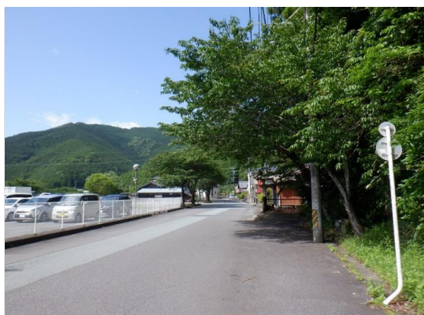
写真17 大紀町 大内山西ノ野・唐子口地区 生活道路に隣接する危険木
