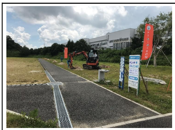
写真4 施工中 啓発用のぼり設置状況
