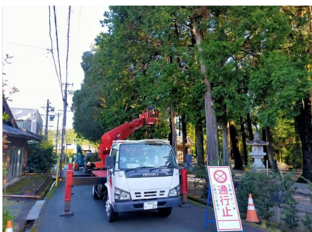
写真3 大紀町野原久保地区 作業中
