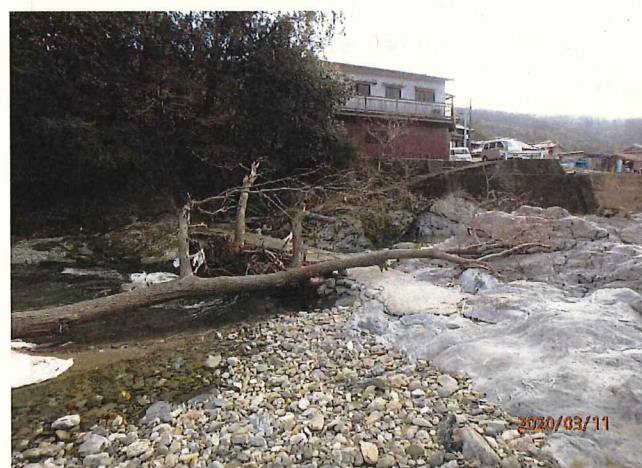
写真5 永会藤地内（危険木撤去前）
