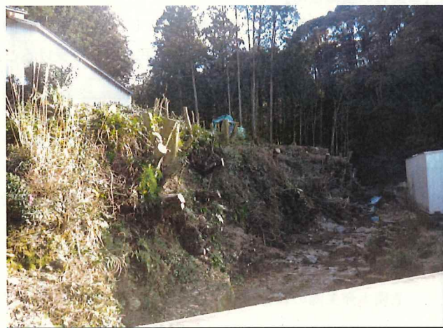
写真4 金輪大谷地内（危険木伐採撤去後）
