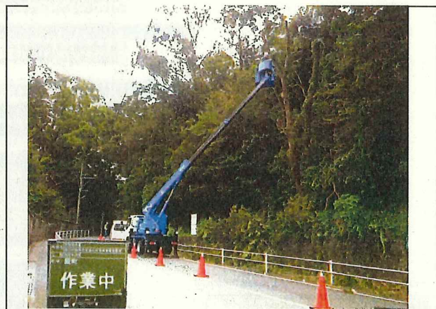
写真6 森林整備(支障木伐採 作業状況)
