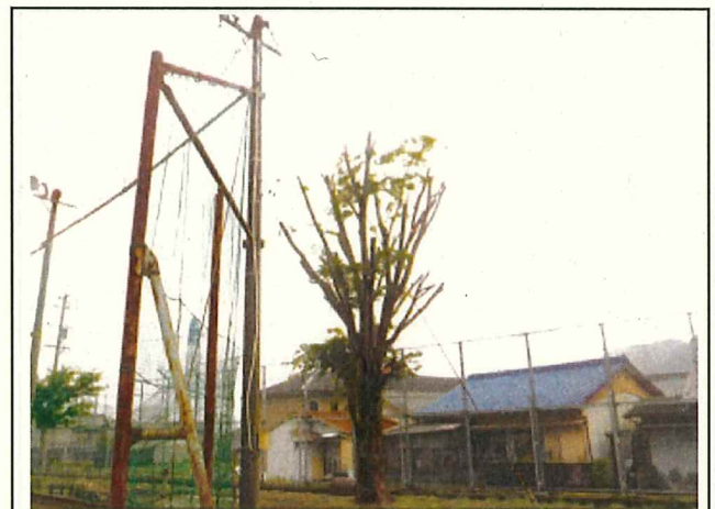
写真6 危険木伐採、剪定（尾鷲中学校）施工後
