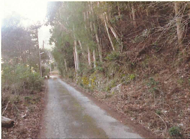
写真7 永会木屋地内県道（危険木伐採前）
