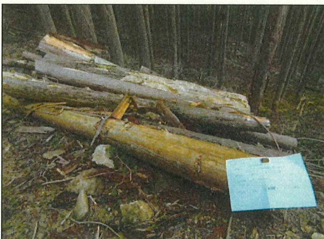
写真3 バイオマス材の搬出のようす
