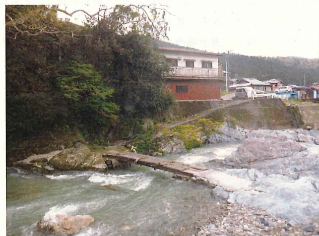
写真6 永会藤地内（危険木撤去後）
