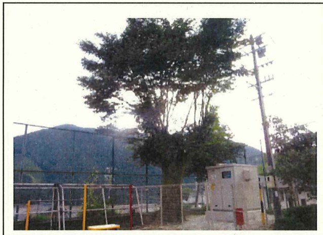
写真3 危険木伐採、剪定（賀田小学校）施工前
