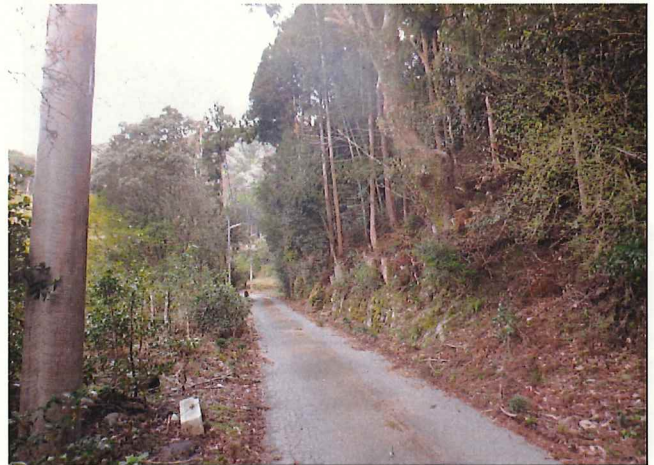
写真8 永会木屋地内県道（危険木伐採後）
