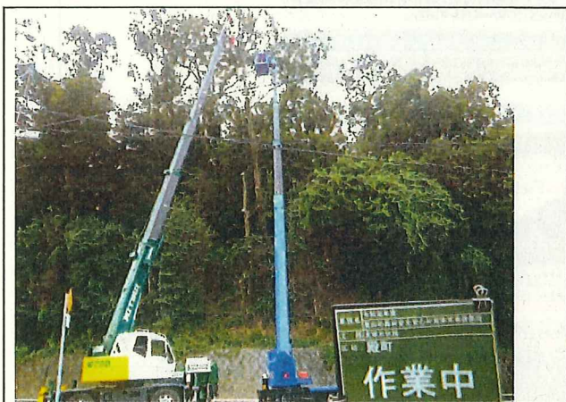
写真5 森林整備(支障木伐採 作業状況)
