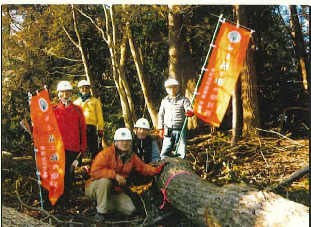
写真5 危険木伐採後のようす
