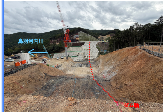
①ダム本体工事 掘削状況（左岸天端より）
