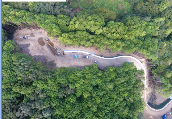
⑦付替道路工事
