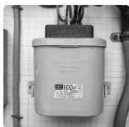
低圧コンデンサー (分電盤に内蔵)
