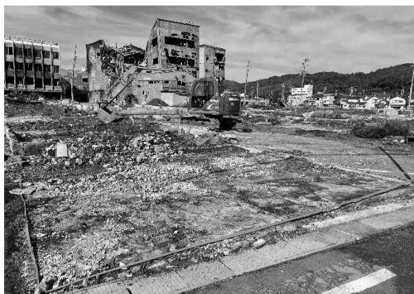
写真3 輪島市内の朝市通り周辺の公費解体の状況
