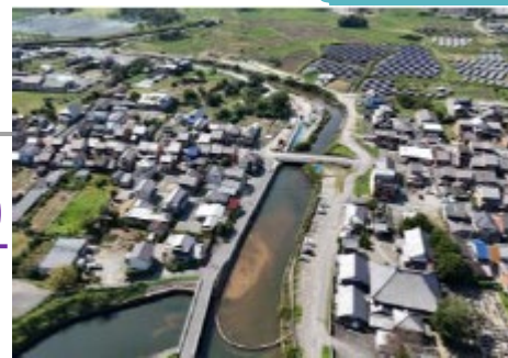
護岸改修事業
