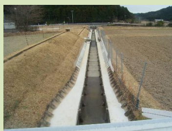
(農業用排水路)
