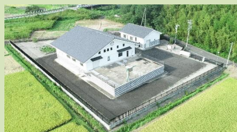
(農業集落排水施設)
