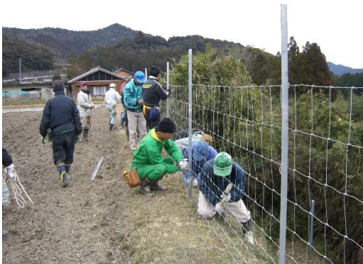
侵入防止柵の設置
