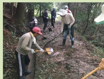
(水路の泥上げ)
