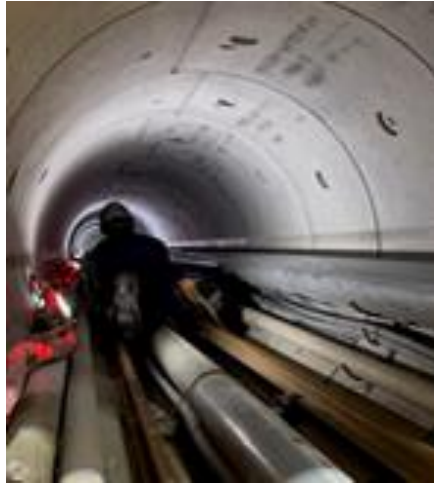
管路（宮川処理区内宮幹線）
