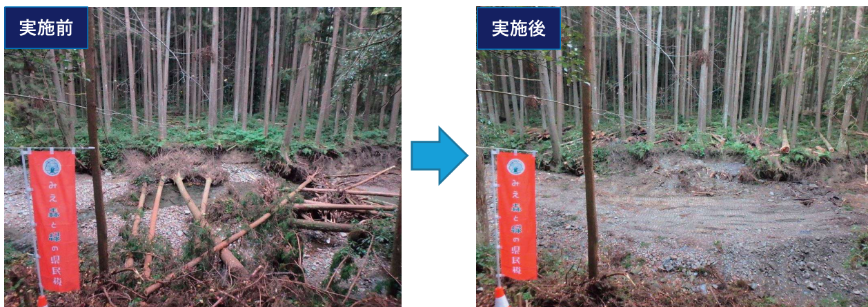
<対策区分1：土砂や流木による被害を出さない森林づくり> 流倒木撤去事業（度会町）
