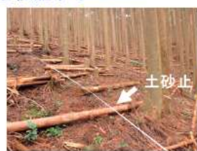
伐倒木を利用した土砂止の設置
